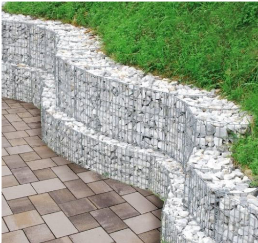
Зураг 5. Хөрсөнд шаардлагатай налуу гаргах бололцоогүй үед буюу хөрсний гулсалтаас найдвартай хамгаалах зорилгоор түших хана хэрэглэнэ (Жишээ зураг).
